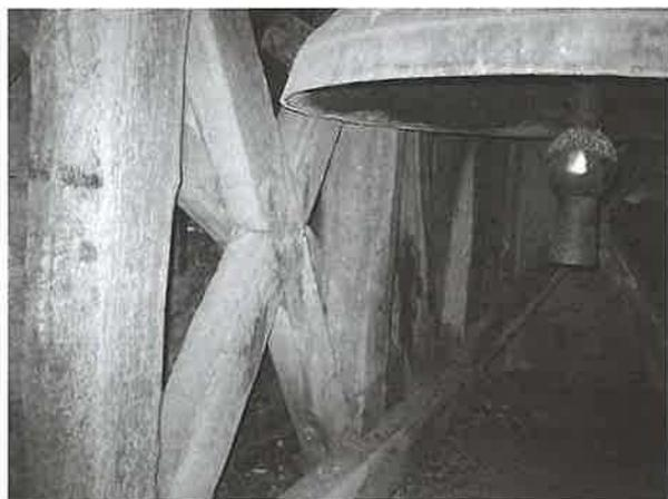
d'autres encore, de sapin et non de chêne, vermoulues. Il en résulte que les assemblages « travaillent » de plus en plus. Encore ignore-t-on dans quel état se trouve la poutraison qui supporte l'ensemble : il faudrait démonter le parquet pour y accéder et décider alors si on peut la maintenir en l'état.
