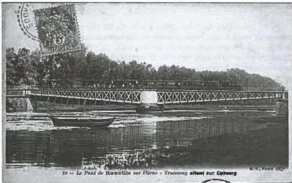
est ouvert à la navigation, il laisse aux navires deux passes égales de 28m60 de largeur. Deux ouvriers ouvrent et referment le pont en 12 minutes.
