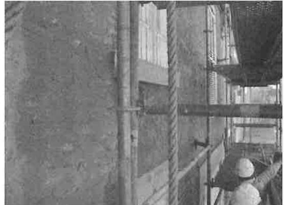
Après déjointoiment, la façade sur rue est recouverte d'une première application d'un enduit à la chaux grise
