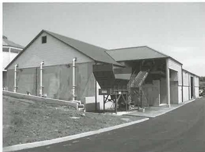
3. Les thermomètres industriels qui suivent la température de la fermentation sont situés à la base des trois tuyaux verticaux. A côté, une cribleuse pour trier le compost.
