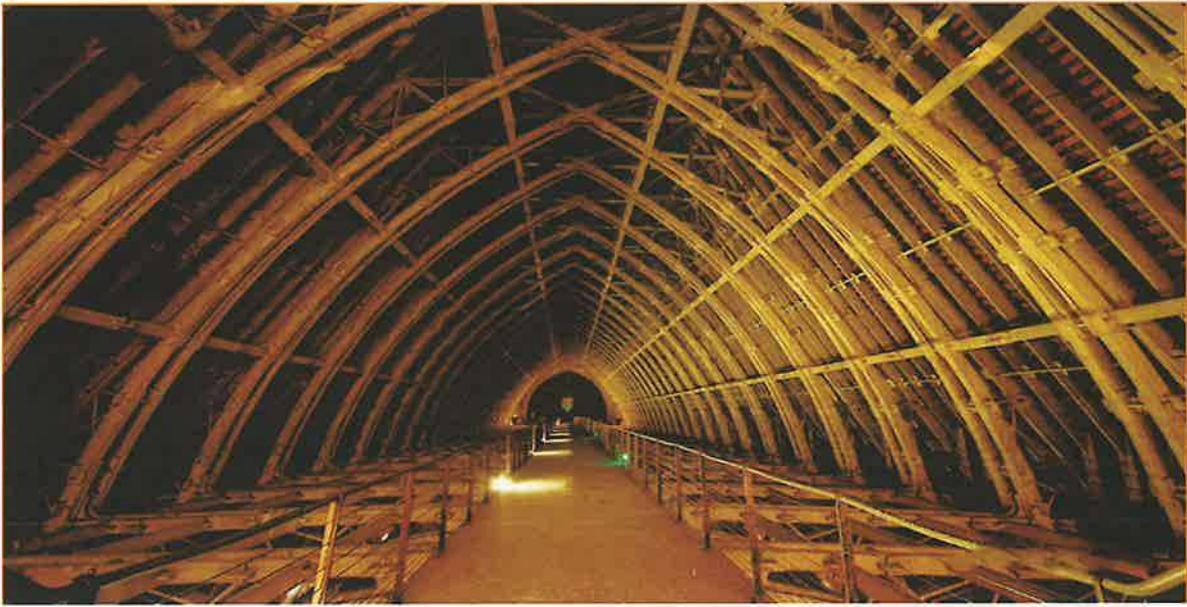
Charpente en béton de la cathédrale de Reims réalisée par Henri Deneux suivant les principes de Philibert de L'Orme
