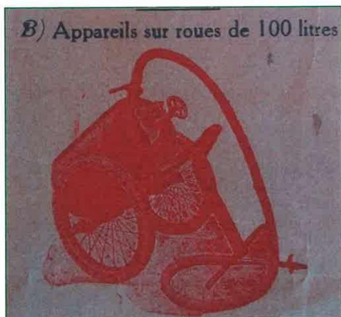
L'entreprise Bouillon Frère propose des extincteurs portatifs contenant 6, 10 ou 20 litres de mousse, ou bien encore des extincteurs sur roues de 100, 200 ou 300 litres. Il était possible d'en voir une démonstration sur la place d'arme à Caen le 4 septembre 1925 : une extinction par étouffement d'un immense foyer imbibé d'huile et d'essence. La commune de Bernières se décide finalement
