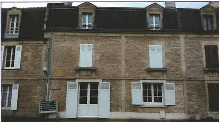
Restitution de la façade ancienne et reprises de la maçonnerie, remplacement des fenêtres PVC par des menuiseries traditionnelles bois ainsi que les volets.
