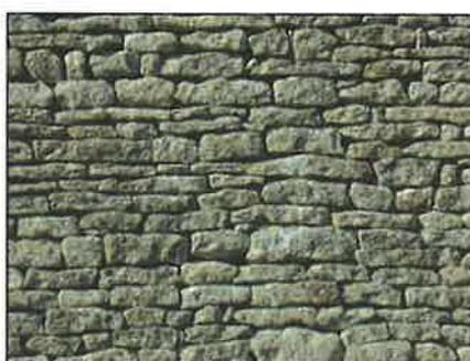
**Fig. 12 : moellons montés à sec sans enduit**
