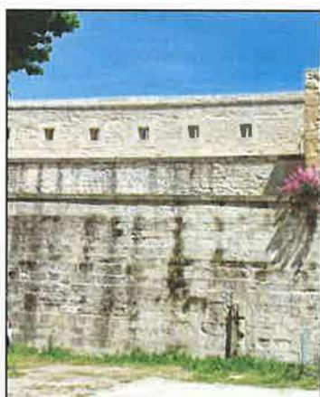
**Fig. 11 : château de Caen, mur en pierre de taille surmonté d'un mur en moellons et d'un mur en plaquettes**
