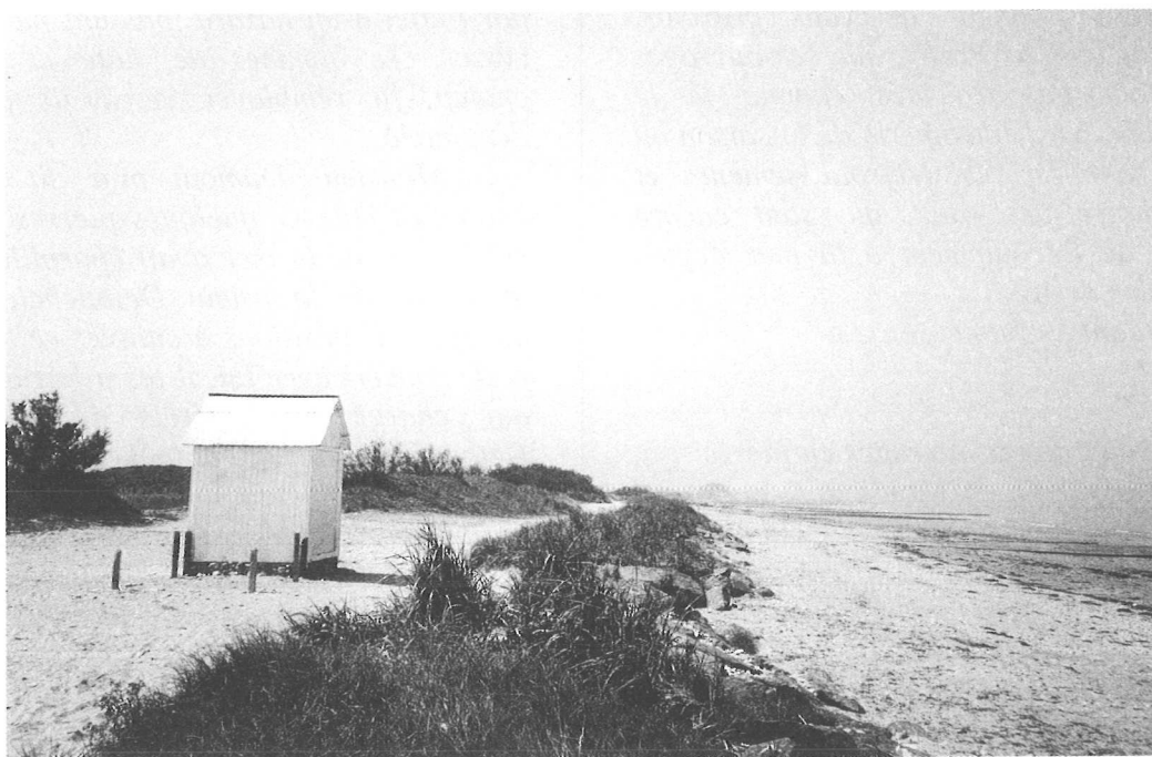
Toujours de nos jours les dunes font l'objet de travaux de défense contre la mer
