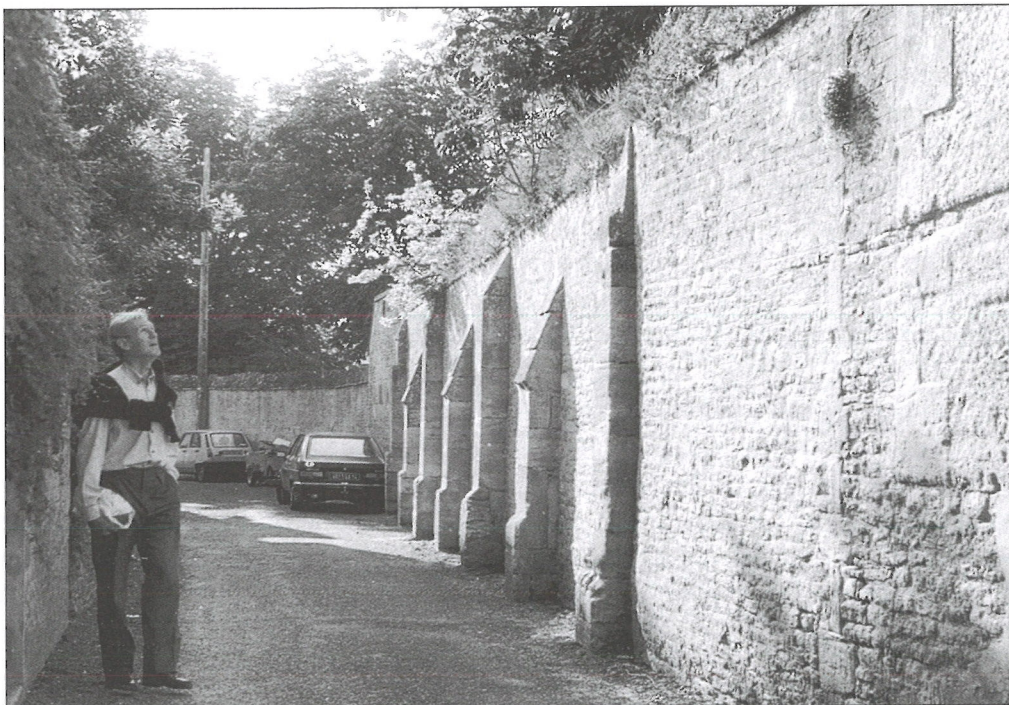
Rue du Vignoble : les très anciens contreforts de la Grande Trésorerie
