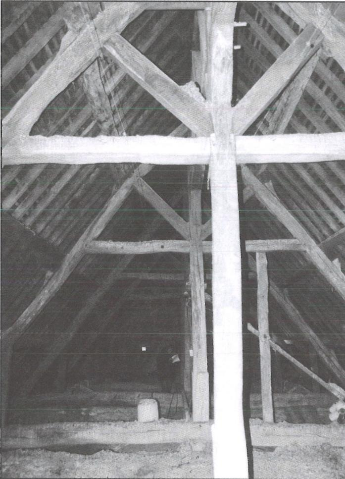
← Vue en enfilade de la charpente du chœur, prise du mu pignon est, où nous venons de découvrir ... mais chut ! c'est encore un secret ! On distingue au premier plan le poteau vertical ou poinçon, reposant sur une poutre horizontale, l'entrait. Plus haut à l'horizontal, le faux-entrait, ainsi que, partant à l'oblique, les deux contrefiches soutenant les chevrons-arbalétriers. On distingue l'assemblage par chevilles.
