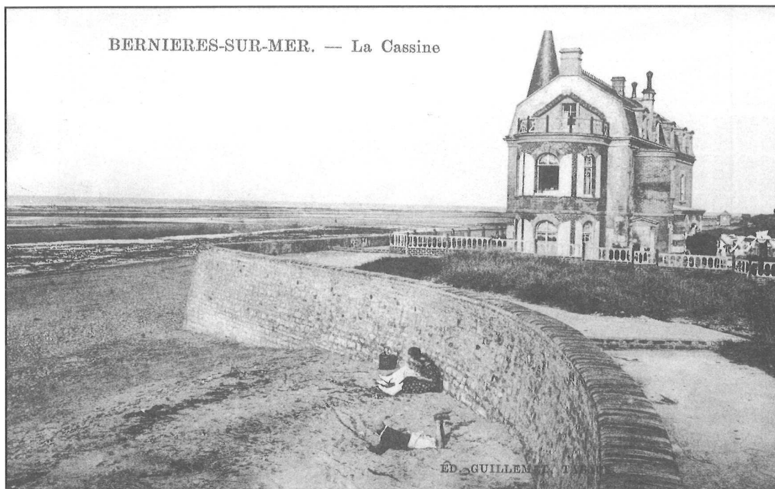
La digue privée protégeant La Cassine
