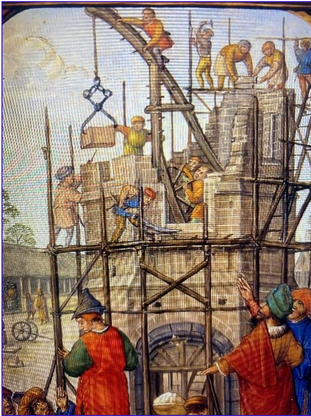
Échafaudage au Moyen Âge
